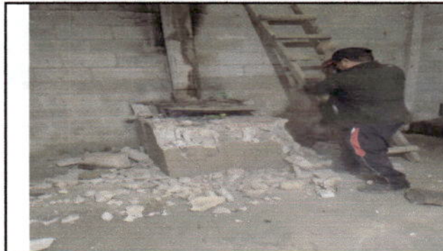
Foto 2: Desinstalación del fogón donde se cambiará la plancha y repello de pared de la cocina del centro educativo
