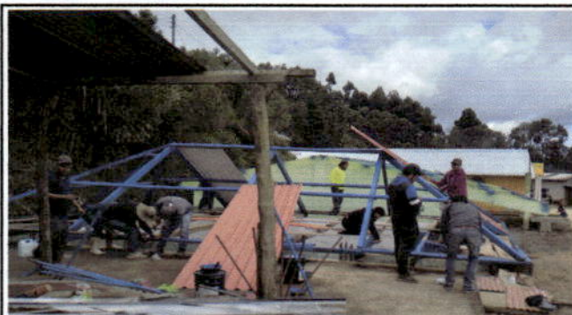
Foto 3: Cambio de techo de la cocina escolar.
