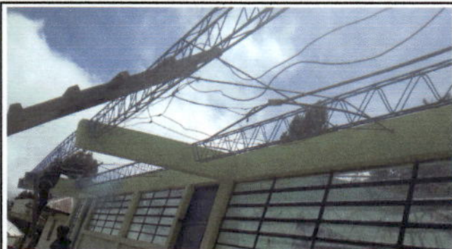
Foto1: Desinstalación del techo de duralita de uno de los módulos por lámina troquelada aluzinc calibre 26
