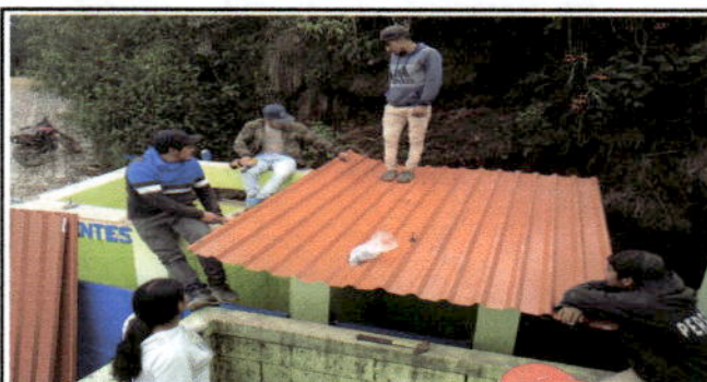
Foto 5: Cambio del techo de los baños del centro educativo.
